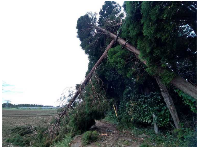
大木戸町の道路では倒木により配電線が大きな被害を受けた
